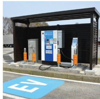
電気自動車 (EV) 充電スタンド工事
