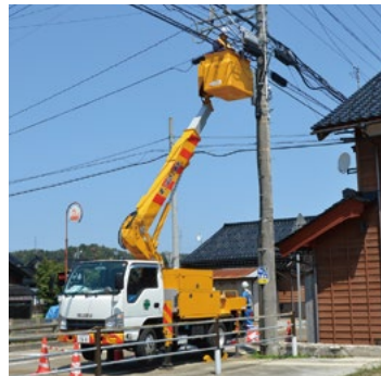
通信ケーブル工事
