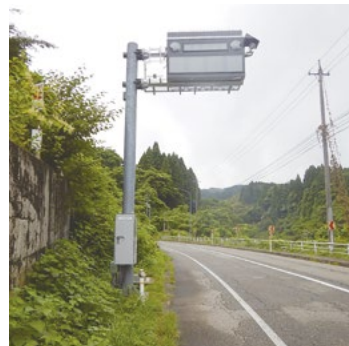
道路付帯設備工事
