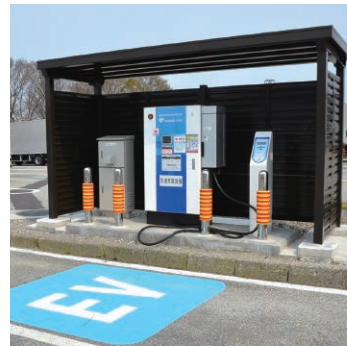
電気自動車 (EV) 充電スタンド工事
