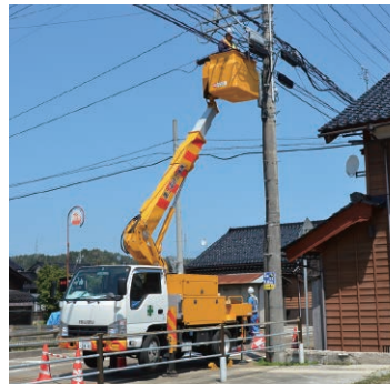
通信ケーブル工事
