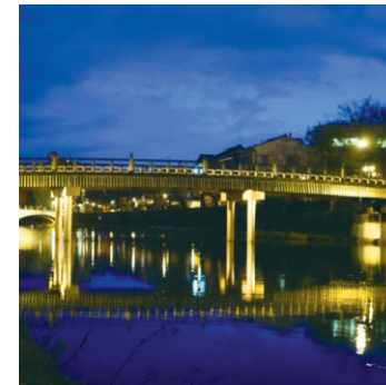
照明設備工事 (LED照明)
