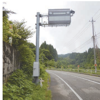
道路付帯設備工事
