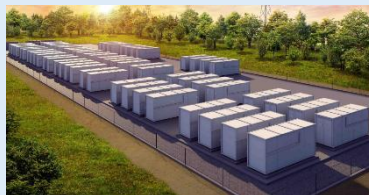
スマートグリッドの構築(蓄電池)
