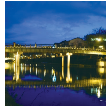
照明設備工事 (LED照明)
