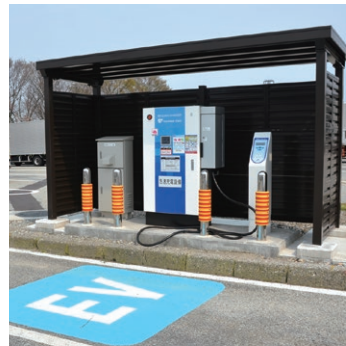
電気自動車 (EV) 充電スタンド工事
