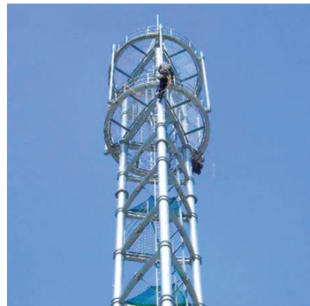
無線系基地局設備工事
