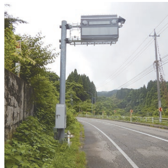
道路付帯設備工事
