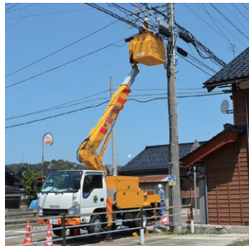
通信ケーブル工事
